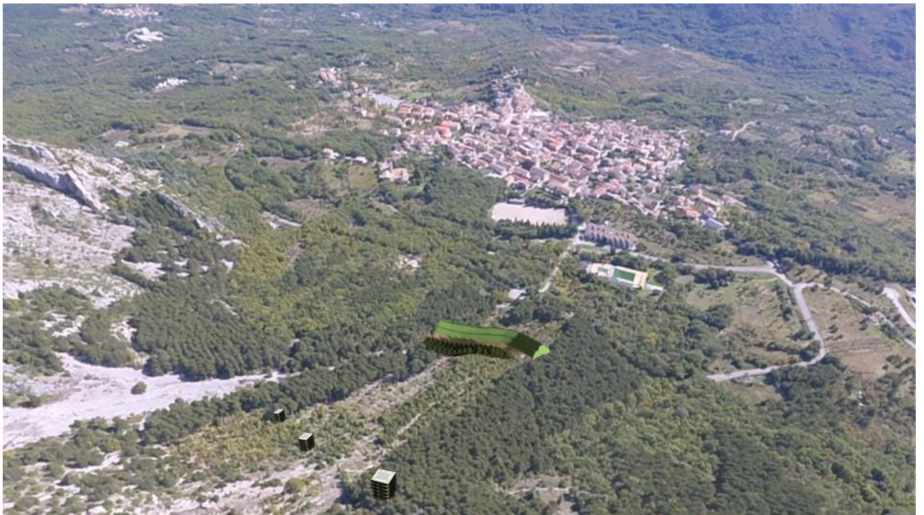
R.5.1_ Vista dall'alto lato ovest dello stato dei luoghi conseguente all'intervento
