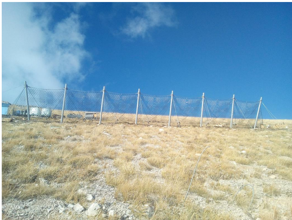
FOTO 2_ Barriera fermaneve in acciaio esistente
