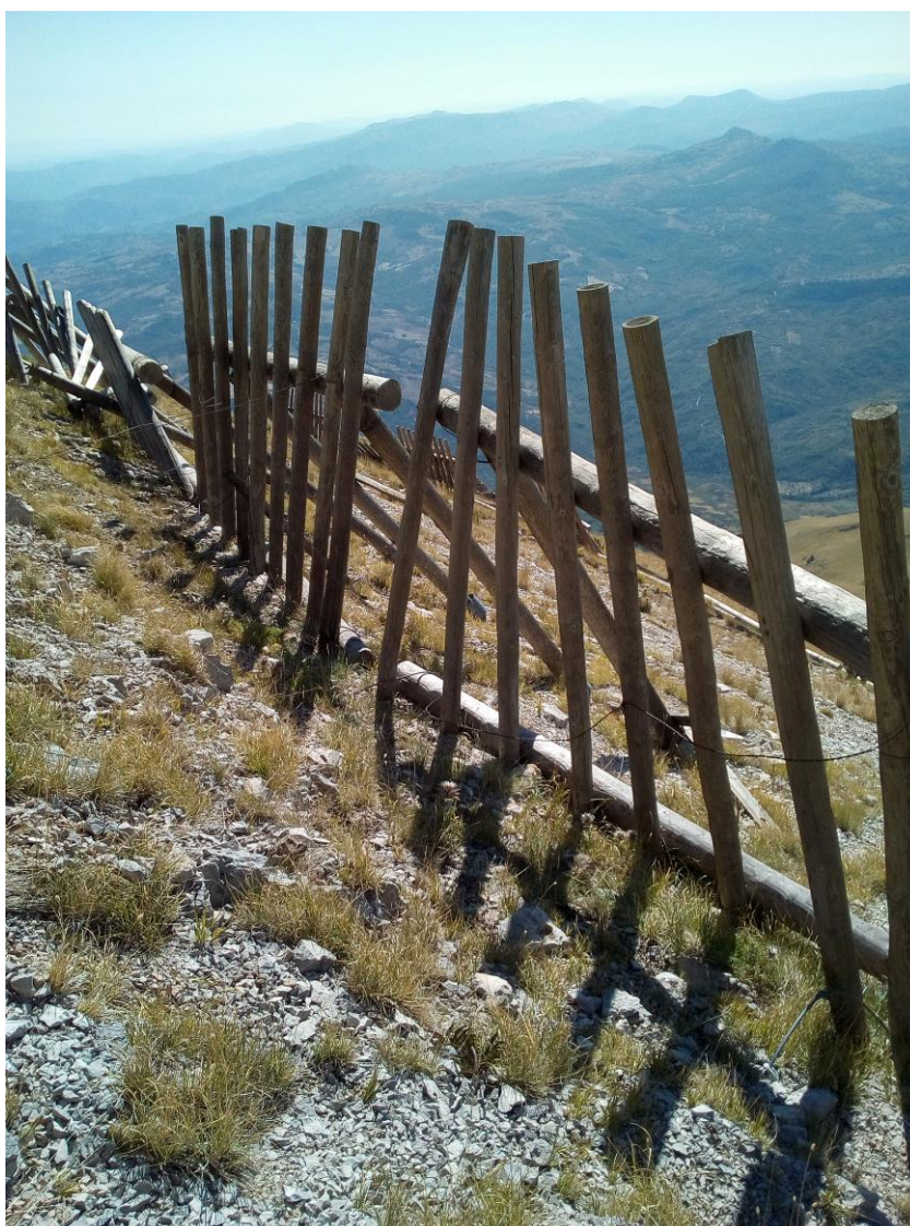
FOTO 1_ Rastrelliere fermeve in legno esistenti
